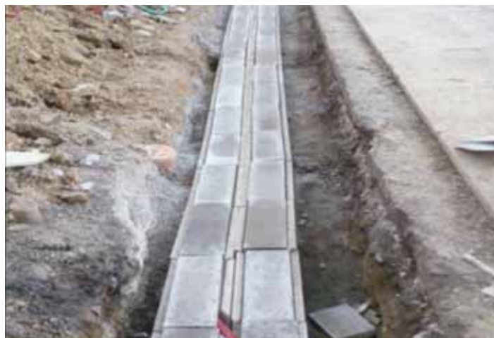
Výstavba zpevněné plochy na p.č. 6 - zabezpečení kabeláže
