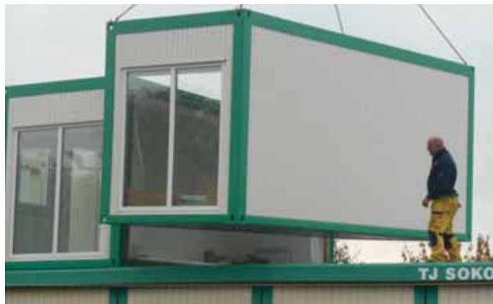
Výstavba nové klubovny TJ SOKOL
