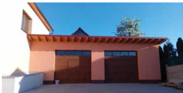
Dokončení prací na parcele č. 6
