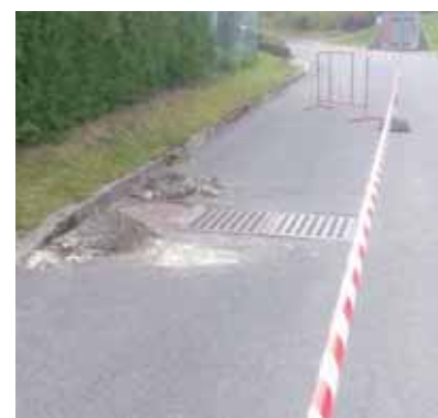
Opravy kanalizačních roštů v ulici Drahy
